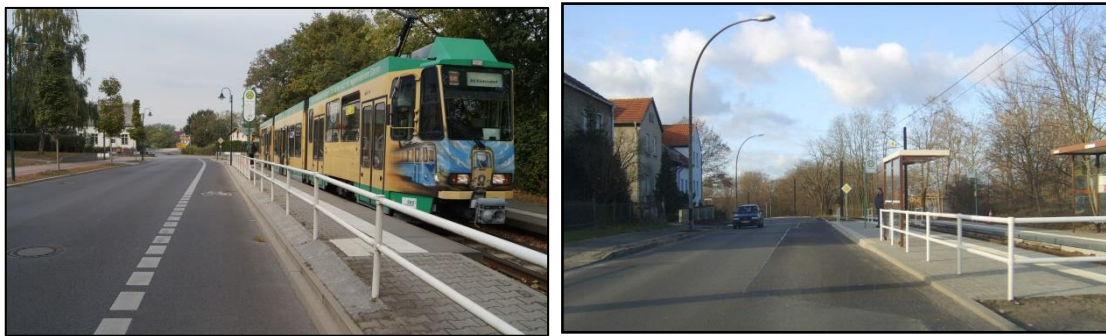
Abb. 12 Bestandssituation im Bus- und Bahnverkehr
