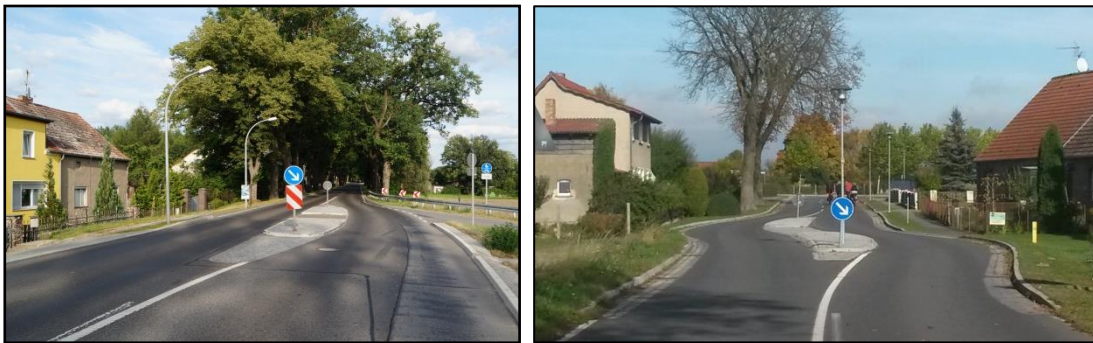
Abb. 42 Beispiele Ortseingangsgestaltung mit Fahrstreifenversatz
