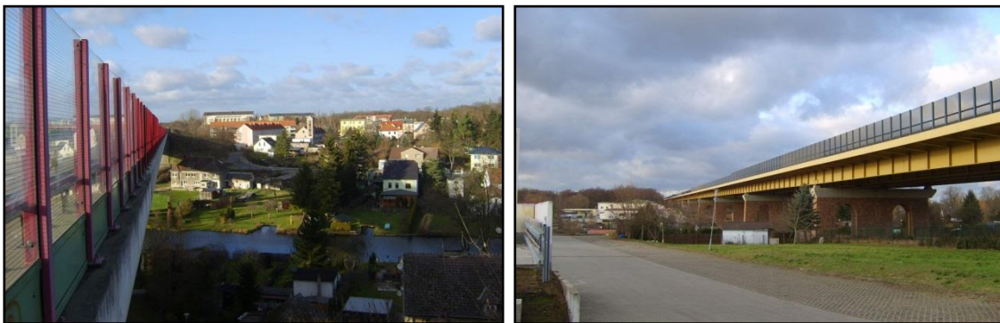
Abb. 2 Autobahnbrücke der BAB 10 im Bereich des Ortskerns Rüdersdorf
