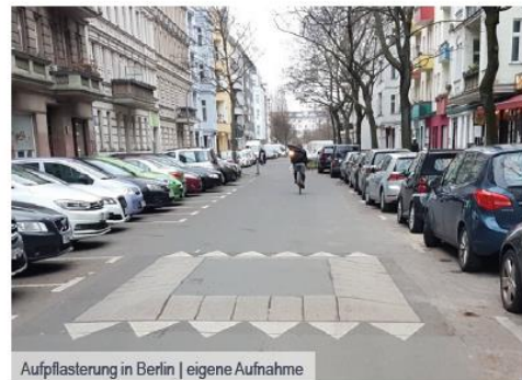
Aufpflasterung in Berlin | eigene Aufnahme
