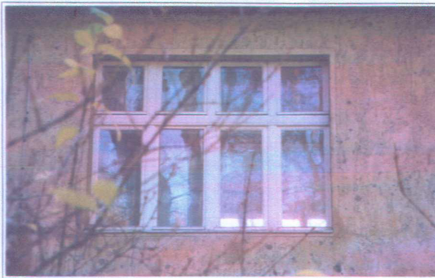
Liegende Fensteröffnung mit stehenden Fensterformaten
