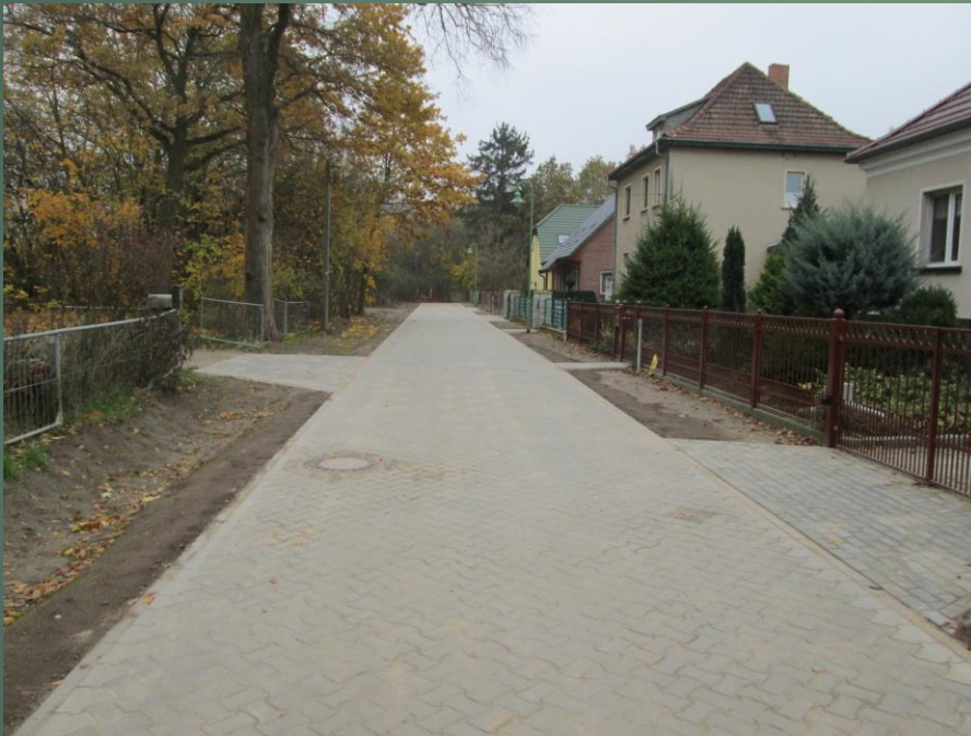
Rosenstraße, Petershagen Pflasterbauweise
