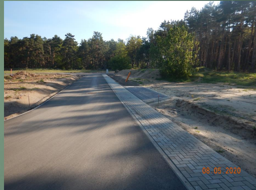
Schmiedeweg, Paaren Glien Asphaltbauweise
