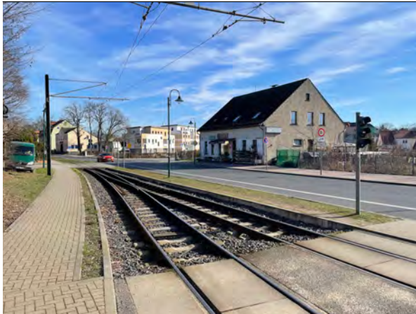
Blickrichtung Ost in die Straße der Jugend, Links. Plangrundstück Straßenbahndepot, Hintergrund: Dr.-Wilhelm-Külz-Str.
