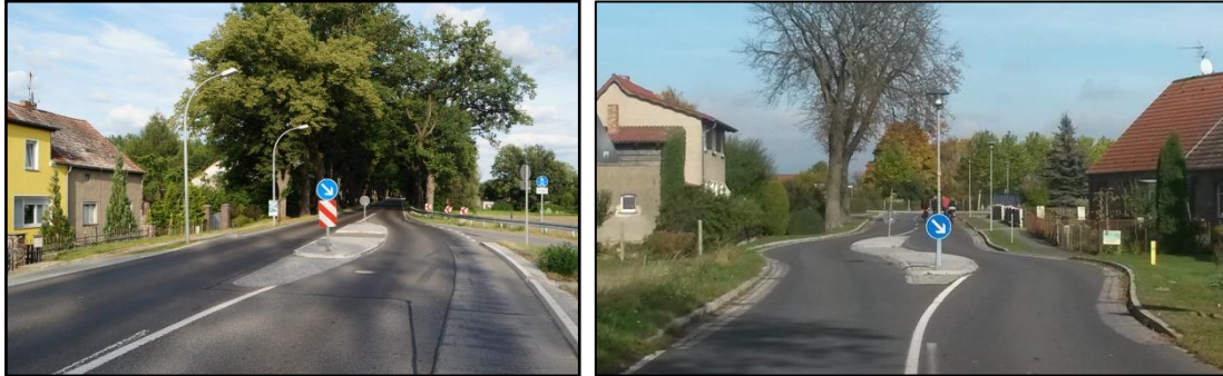
Abb. 44 Beispiele Ortseingangsgestaltung mit Fahrstreifenversatz
