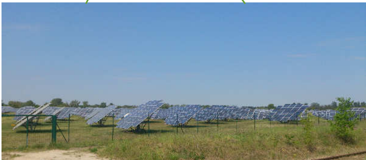
Abb. 19 PV-Freiflächenanlage im Gewerbegebiet Herzfelde
