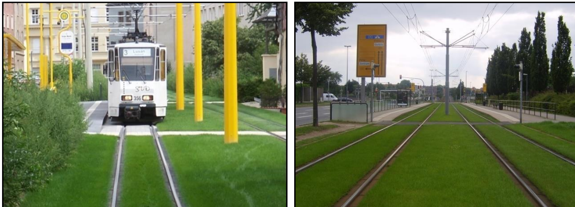
Abb. 44 Beispiele für Rasengleis Gera, Dresden
