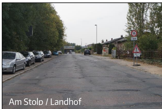
Abb. 6 Oberflächendefizite im Landesstraßennetz
